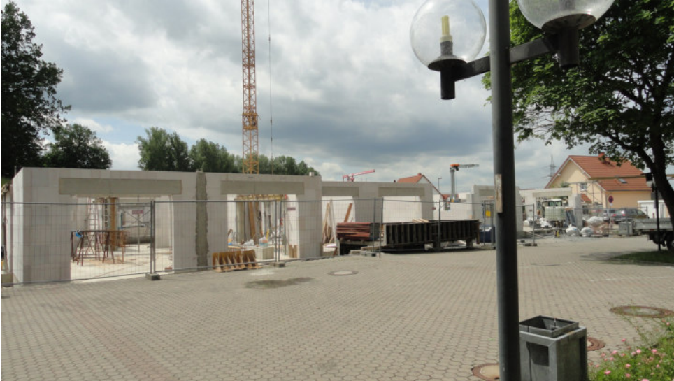
linke Gebäudeseite: Tagespflege
