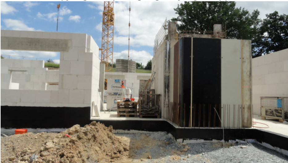
von links: Empfang, Haupteingang, Aufzug, Treppenhaus
