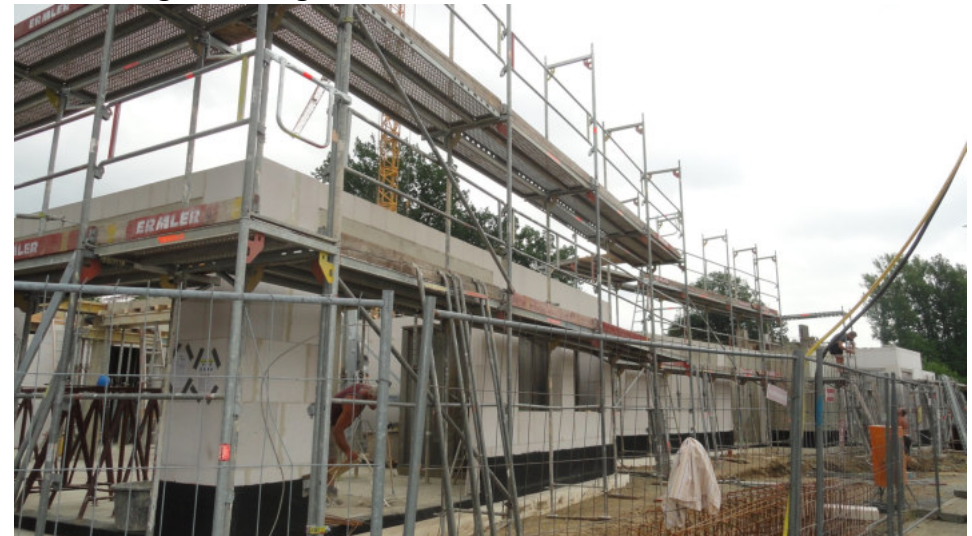
Einrüstung des Erdgeschosses
